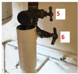
**5.** Dévisser le bouchon sous le détendeur avec la clef à molette. *Attention à ne pas perdre le joint sur le pas de vis.*
