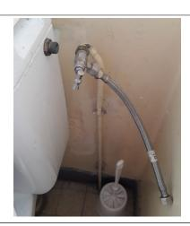
**9.** Pour la machine à laver, fermer le robinet mural, brancher le tuyau flexible et visser le bouchon de purge en plastique noir à l'avant, en-bas et à droite de la machine.
