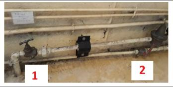
11. Dans la fosse du compteur d'eau : ouvrir le robinet de purge (1) (tourner à fond dans le sens inverse des aiguilles d'une montre pour désactiver la purge) et ouvrir le robinet d'arrêt avant compteur (2). Il ne doit pas y avoir de fuite dans la fosse. Ne pas refermer la fosse tout de suite.
