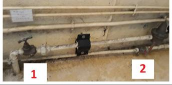
14. Dans la fosse du compteur d'eau, vérifier que le compteur ne tourne pas (la petite aiguille ne doit pas tourner) et refermer la fosse.
