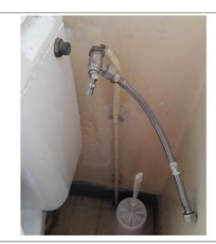
**11.** Lorsque le chauffe-eau est vidangé, dévisser et retirer (à l'aide d'une clef à molette) les deux robinets (5) et (6) sous le chauffe-eau. *Attention à ne pas perdre les joints sur les pas de vis.*
