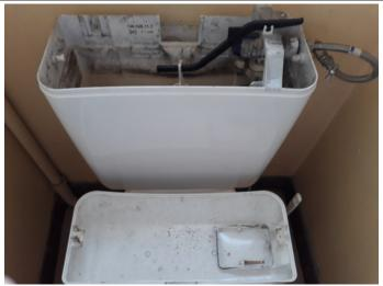
10. Pour les toilettes du haut du chalet, dévisser, à l'aide d'une clef à molette, le tuyau flexible d'arrivée d'eau et le laisser pendre.
